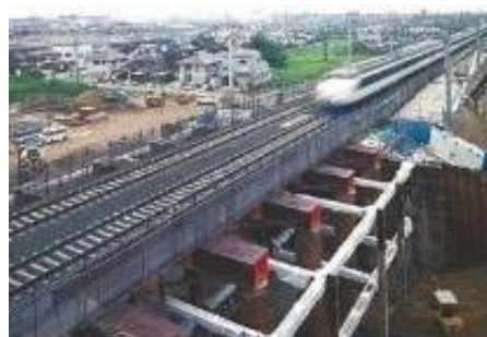
Tokaido Shinkansen Minowa Overpass
