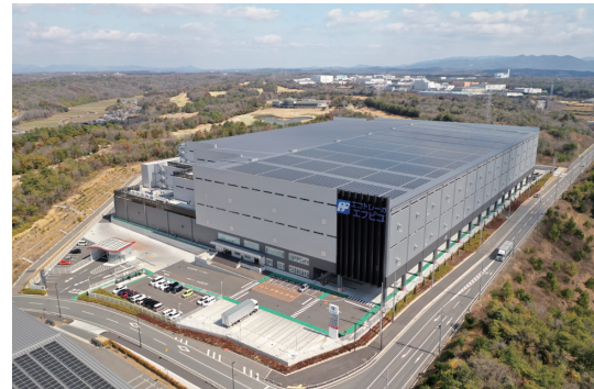
関西工場 太陽光発電設置
