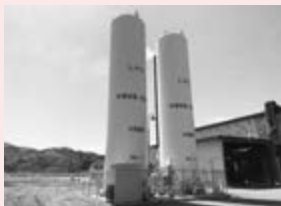
2022年10月 第3バイオセンターにLNGサテライト設備を導入いたしました。
