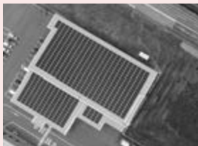
滋賀パッケージセンターの屋根に太陽光パネルを設置いたしました。
