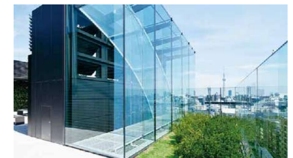
自然換気システム（屋上のソーラーチムニー）
