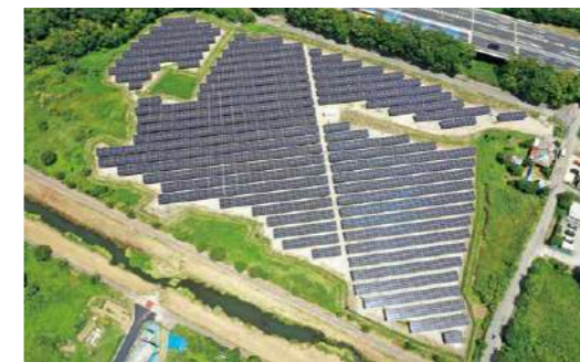
太陽光発電設備 千葉市若葉区
