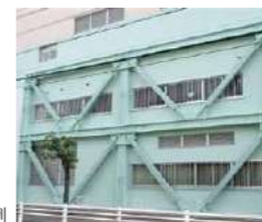
耐震補強事例
