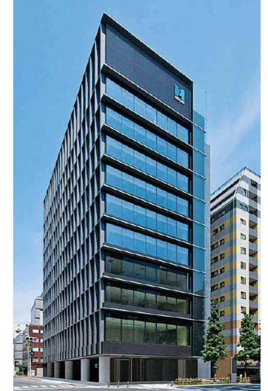
ヒューリック本社ビル
