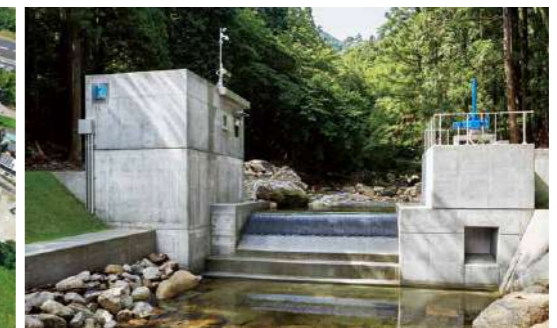
鴨川小水力発電所
