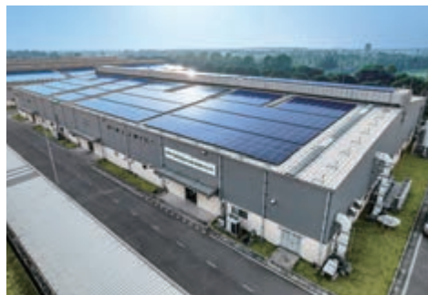
〈KAGA ELECTRONICS (VIETNAM) CO.,LTD.の太陽光パネル〉
