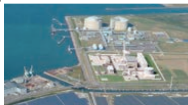
ひびき発電所 竣工イメージ
