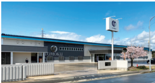
青森工場 移転後の建屋外観
