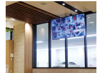
整備士の行う作業をお客様がご確認いただけるモニターをショールームに設置
