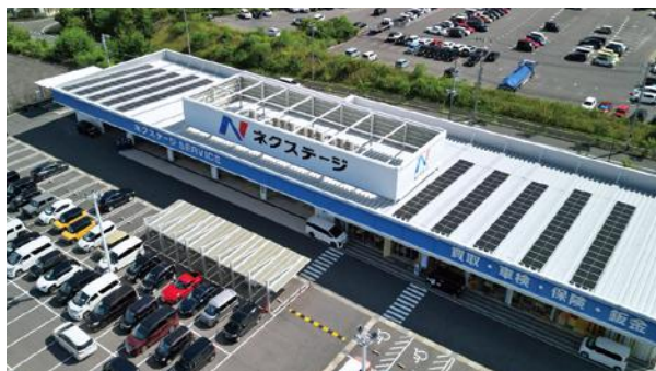
土岐多治見店に設置された太陽光パネル
