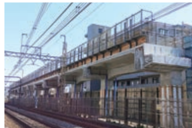
京王線連続立体交差事業
