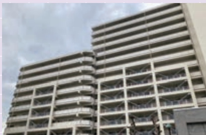
織部住宅耐震補強工事
