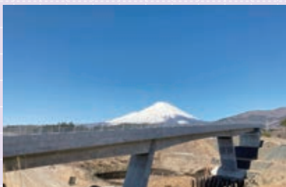
大御神西跨道橋 (静岡県駿東郡小山町)
