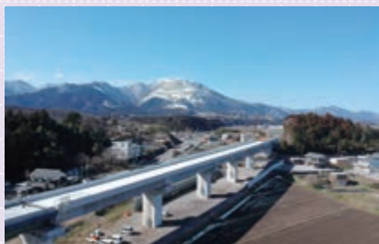
北勢第二高架橋 (三重県いなべ市)
