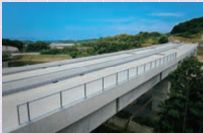
袋川橋 (熊本県水俣市)
