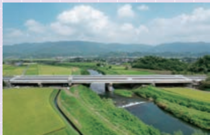
池島川橋床版取替工事 (宮崎県えびの市)
