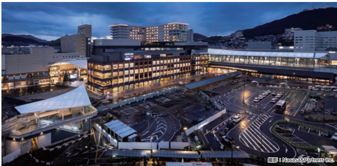
JR長崎駅ビル新築工事（長崎県）
