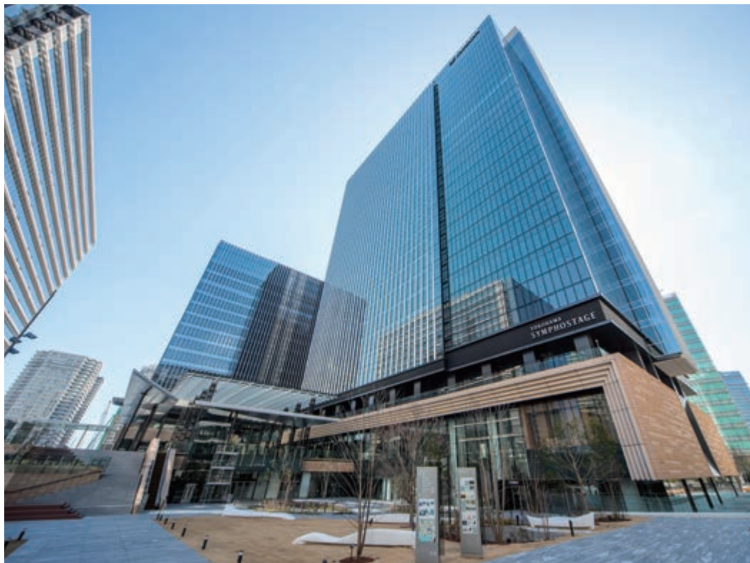
横浜シンフォステージ新築工事（神奈川県）
