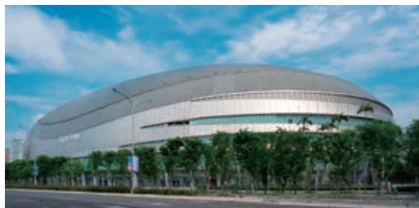
台北ドーム新築工事（台湾）
