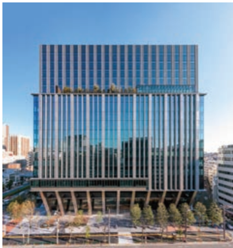
五反田JPビルディング新築工事（東京都）
