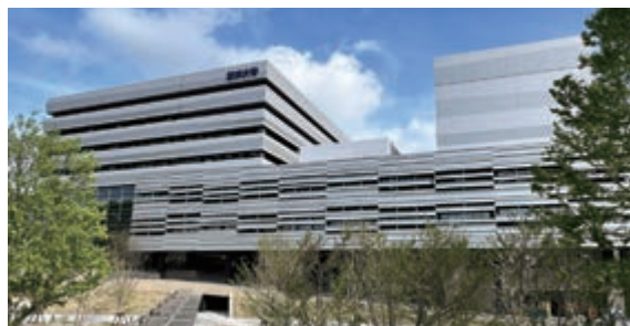
東洋大学朝霞キャンパス整備工事（埼玉県）
