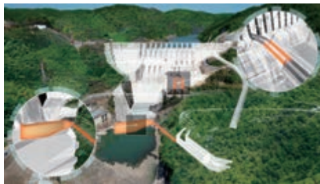
新丸山ダムの下流締切工（左）と既設丸山ダム仮排水路トンネル閉塞工（右）で「クリーンクリート ® 」を打設（オレンジ色が適用部分）
