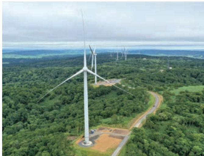
川西ウインドファーム建設工事（北海道）
