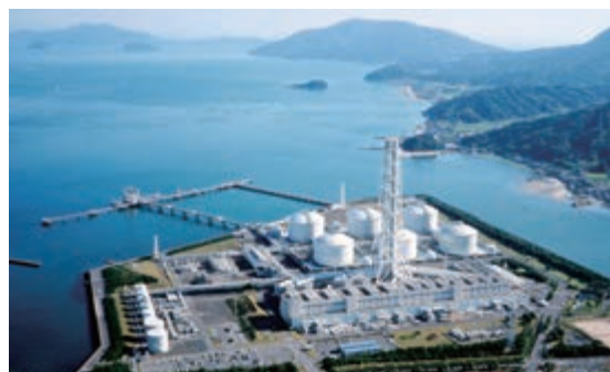
柳井発電所全景
