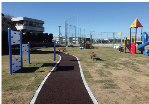
アスウッド工法（木材チップ舗装）
