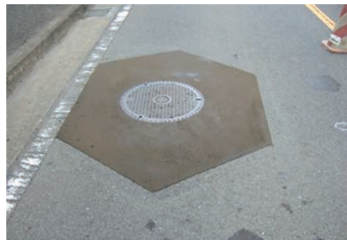
スーパーロメンパッチの施工例
