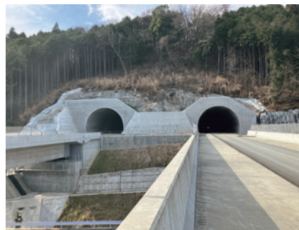
新東名高速道路 湯船原トンネル工事
