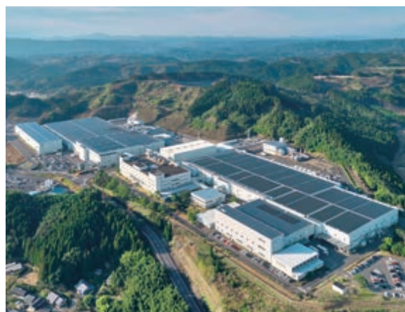
ラピスセミコンダクタ 宮崎第二工場
