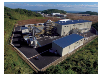
溶融・再資源化処理施設
