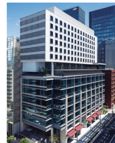
OVOL日本橋ビル
