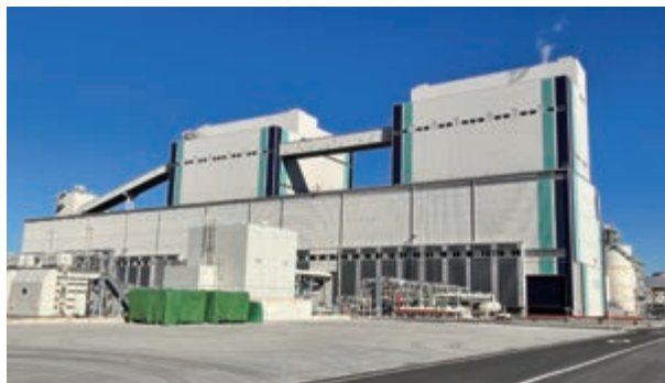
最新鋭の横須賀火力発電所2号機の運転を開始
