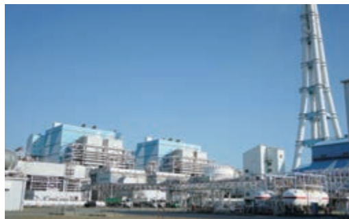
碧南火力発電所4号機においてアンモニアへの燃料転換の実証試験を開始
