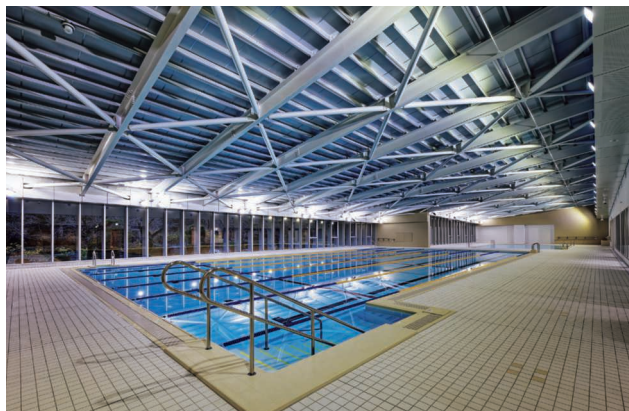
工事名：いなべ市民温水プール (仮称) 新築工事 発注者：いなべ市
