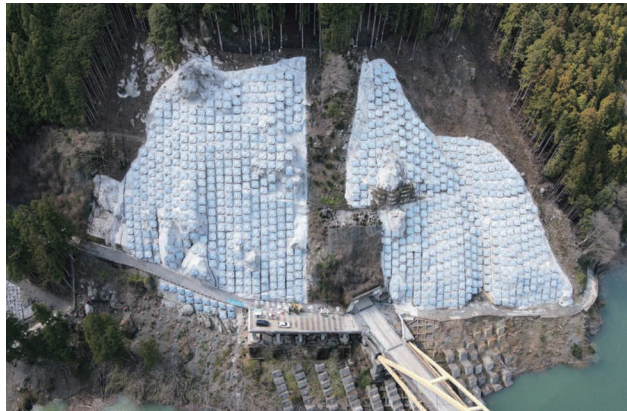
工事名：高原トンネル上部斜面对策工事 発注者：国土交通省近畿地方整備局
