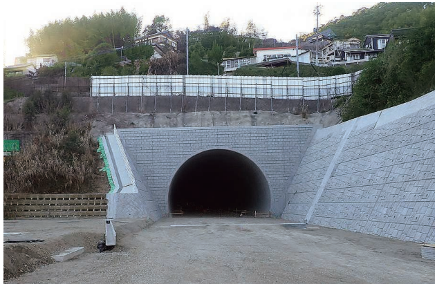
工事名：佐世保道路 天神山トンネル工事 発注者：西日本高速道路株式会社
