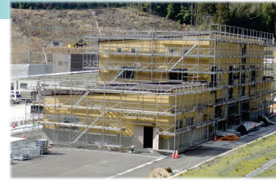
浸出水処理施設の外壁補修工事
