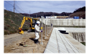
防災調整池の補修工事
