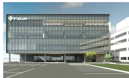
岡崎工場新棟 2024年9月 操業予定
