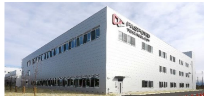
R&D棟（2023年11月竣工）
