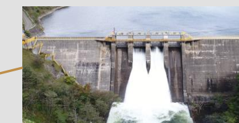
幌満川水力発電所
