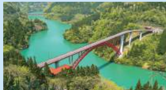
庄川峡観光船からの見え方や、利賀村へのゲートの役割をコンセプトにした「利賀大橋」
