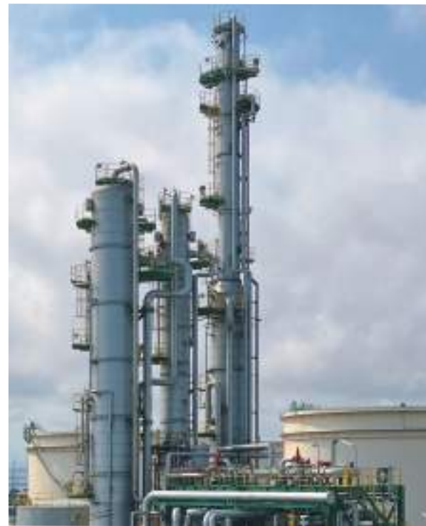
日本初となる苫小牧CCS実証試験センターの分離・回収設備
