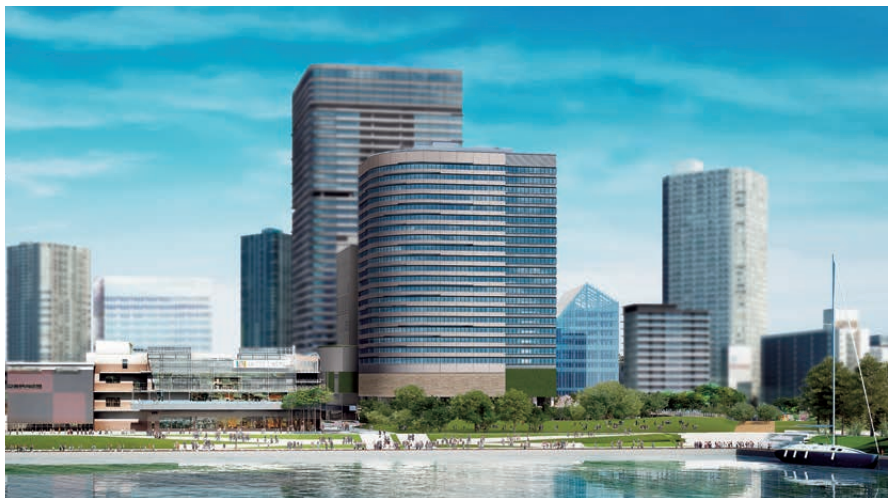
▲ (仮称)豊洲二丁目駅前地区第一種市街地再開発事業 2-1街区B棟新築工事 (東京都江東区) 発注者：三井不動産株式会社
