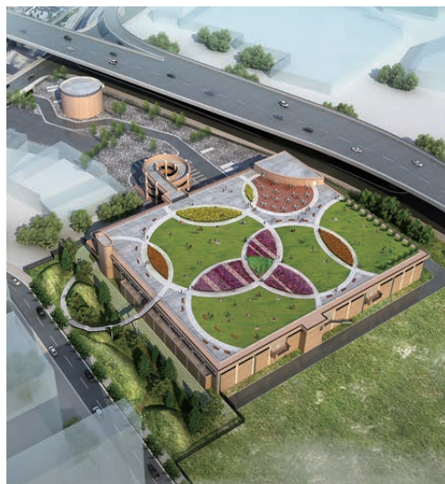
▲ 大阪市海老江下水処理場改築更新事業 (大阪府大阪市) 発注者: 海老江ウォーターリンク株式会社
