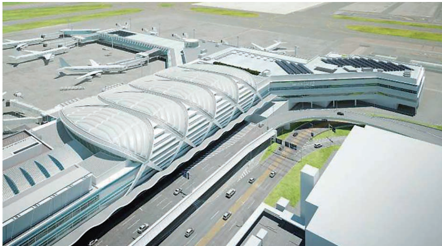
▲ 東京国際空港第2ターミナル国際線施設建設工事 (東京都大田区) 発注者：日本空港ビルデング株式会社
