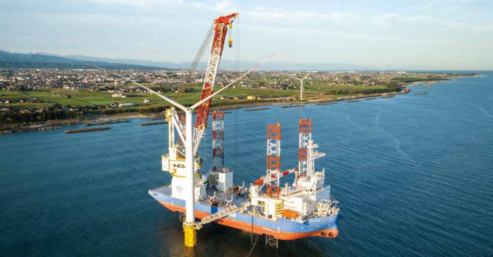
洋上風力発電施設建設用のSEP船「BLUE WIND」
