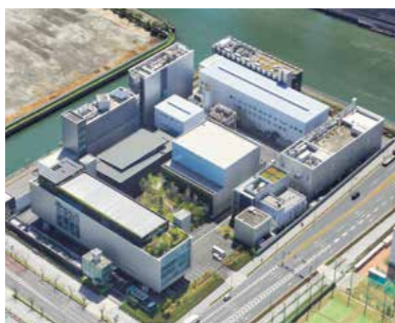
技術研究所外観(東京都江東区)
