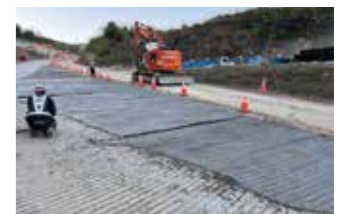
SUSMICS-C(左)と普通コンクリート(右)との比較
