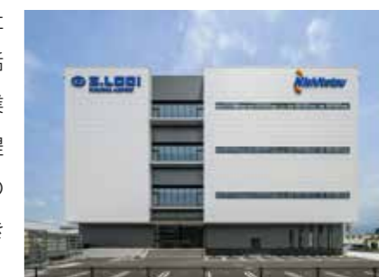
S・LOGI福岡空港(福岡県福岡市)
