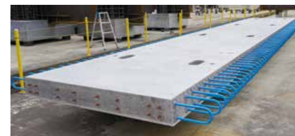
完成したPC道路橋床版
