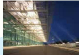
2007 チャンギ国際空港第3ターミナル (シンガポール) 幅300m×奥行215mの鉄骨 トラスのリフトアップは世界初
