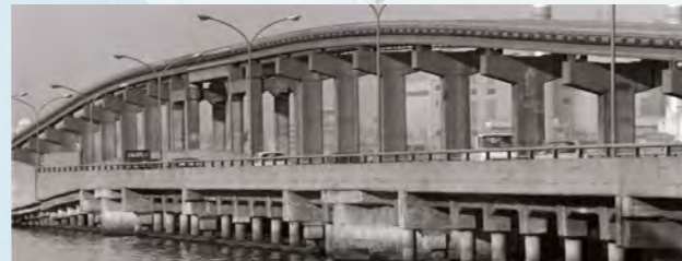
首都高速羽田1号線と東京モノレール
