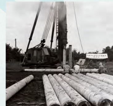
ONAパイルのハンマー打撃試験
