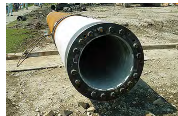
RSCP 杭（パイル）
