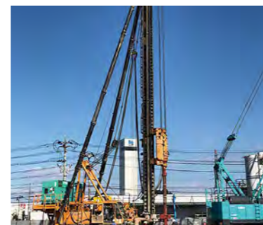
既製コンクリート杭工事
