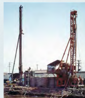
寝屋川護岸工事
