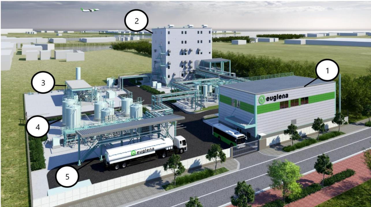
①事務棟 ②反応装置棟 ③用役設備 ④貯蔵タンク ⑤出荷場
