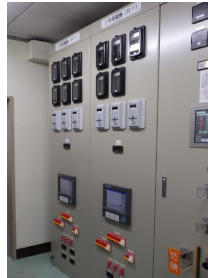
納入した発電機制御装置
