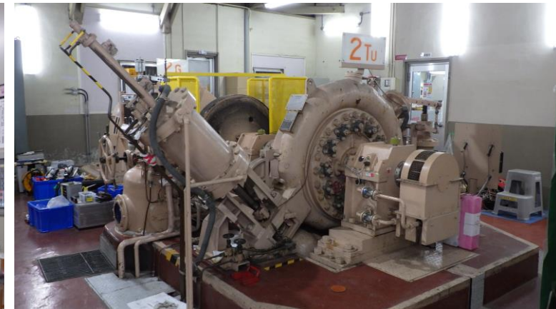
水車発電機外観
