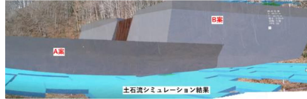
現場投影した砂防堰堤のBIM/CIMモデル
