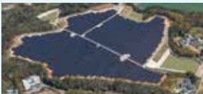
大仏山メガソーラー発電所
