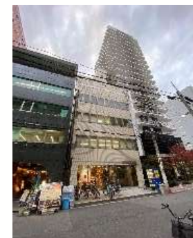
大和本町ビル
