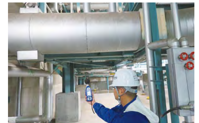
騒音測定の様子
