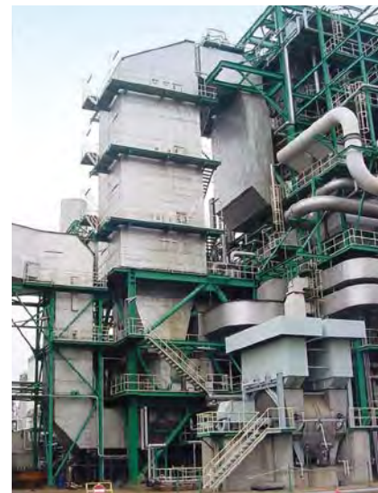
排煙脱硝装置
