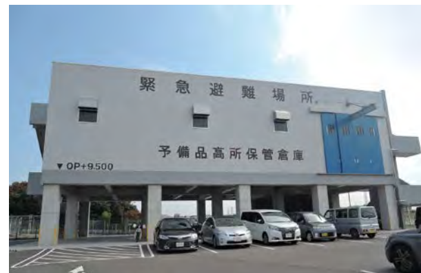
高所保管倉庫(堺製油所)
