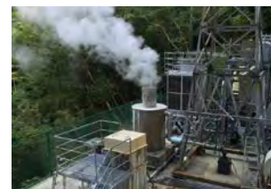
下田温泉バイナリー発電所
