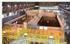
豊羽鉱山 本山坑廃水処理場の様子
