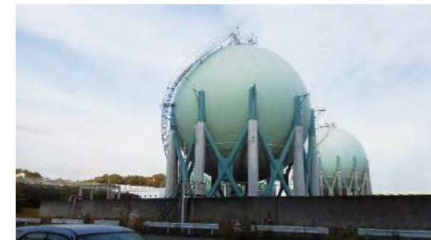
球形タンクのブレース(筋交い)補強
