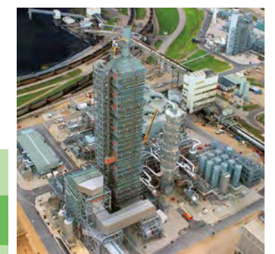
CO 2 回収プラント(米国テキサス州)
