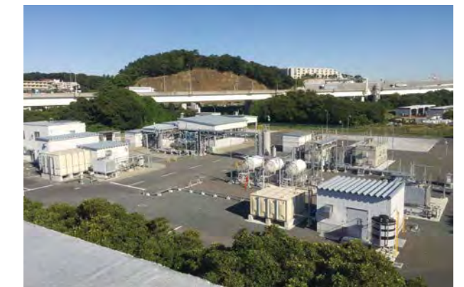
水素製造出荷センター(横浜市中区)
