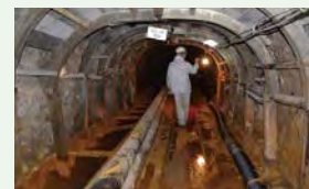
花輪鉱山 坑道点検の様子
