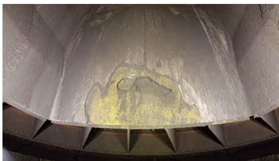
バンカー内部コンベアのケーシング
