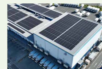
チルド・フローズン日野センター (セブン-イレブン店舗向け物流センター)
