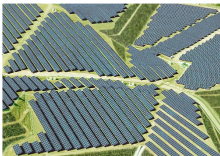
(Kakuda Solar Power Plant)
