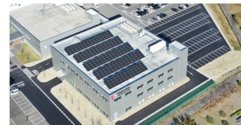
ファスフォードテクノロジー R&D棟
