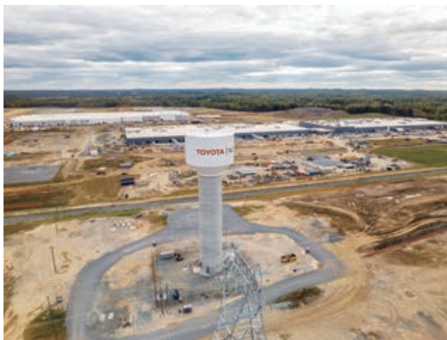
建設中の電池工場
